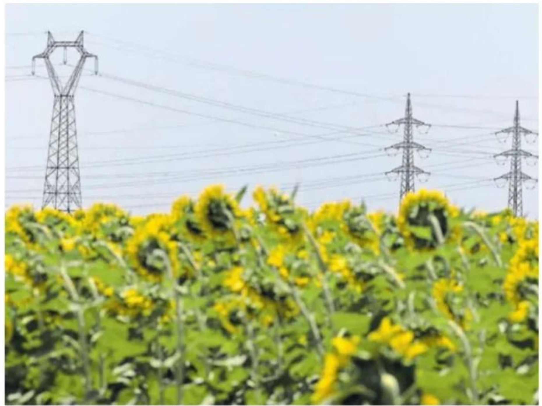
Tendido eléctrico a las afueras de Sevilla. PACO PUENTES
